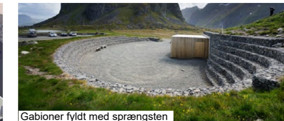
Gabioner fyldt med sprængsten
