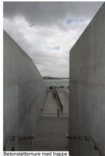
Betonstøttemure med trappe
