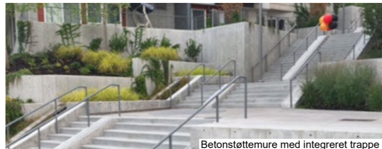
Betonstøttemure med integreret trappe
