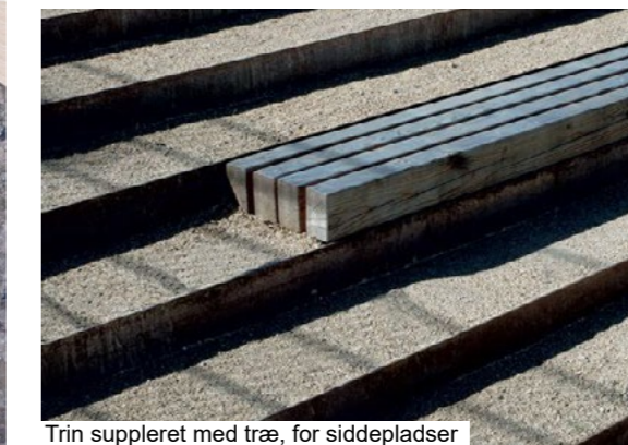
Trin suppleret med træ, for siddepladser
