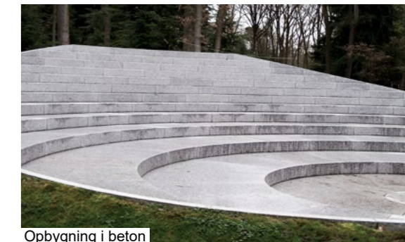
Opbygning i beton
